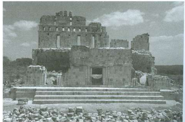
Figura 13. Panorámica final del costado sur del Edificio 93 de Dzhekkabtún (foto: A. Benavides C.).
